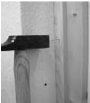
Bild 27: Montage der Wandanschlussleisten
