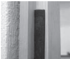
Bild 14: Kompriband (z.B. mit 300 Pascal 20 x 2,0 mm)
