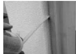
Bild 8: Zwischenraum ausschäumen
