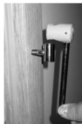
Bild 18: Bandmontage 3-tlg. Band
