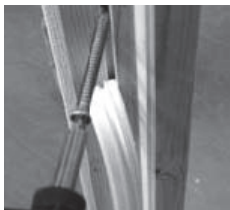
Bild 15: Schrägverschraubung des Türstockes
