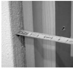
Bild 6: Abstand Blindstock Wandaubung
