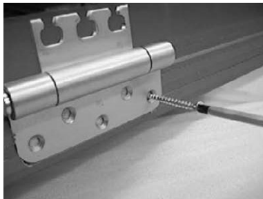
Bild 20: Band mit Türblatt verschrauben
