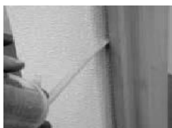
Bild 6: Zwischenraum ausschäumen
