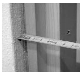
Bild 4: Distanz Blindstock Wandlaibung
