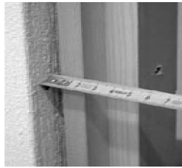
Bild 6: Abstand Blindstock Wandaubung
