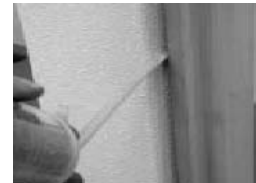
Bild 8: Zwischenraum ausschäumen
