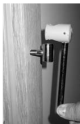
Bild 17: Bandmontage 3-tlg. Band
