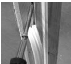
Bild 15: Schrägverschraubung des Türstockes
