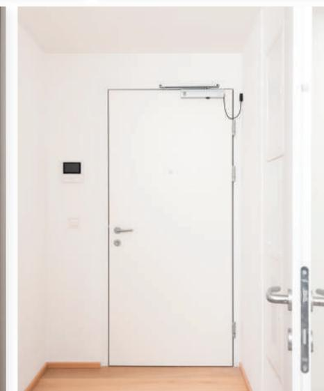
**oben links:** Bei den Wohnungseingangstüren wurde das DANA Modell Dominant 3 mit Einbruchschutz Widerstandsklasse 2, Mehrfachverriegelung, Bandsicherung und einem automatischen Türschließer für den Brandfall verbaut.
